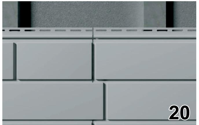
Дойдя до верхнего края стены, потребуется подрезать по высоте панели, устанавливаемые в последний ряд. Отмерьте расстояние от предпоследнего ряда панелей до внутренней части универсального J-профиля 7/8 дюймов. От полученного результата вычтите 5-7 мм. Отрежьте верхнюю часть панели, руководствуясь полученными вычислениями. Вставьте подготовленную панель в замок нижней панели. Слегка согнув панель, вставьте ее в универсальный J-профиль 7/8 дюймов.
